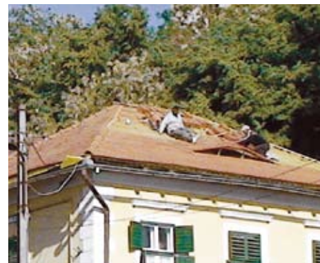
Die dringendst notwendige Dachreparatur kurz vor dem Abschluss
