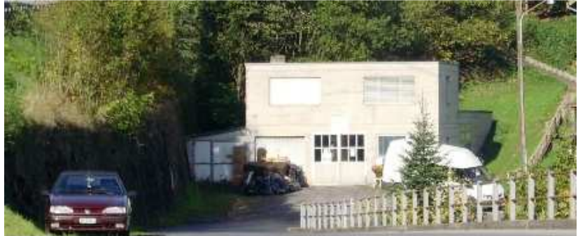
Papageno Zwischenlager in Murg am Walensee
